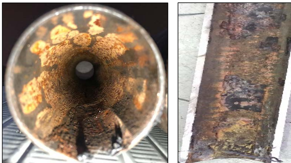
Рисунок 1 – Внешний вид образцов трубопроводов, вырезанных из поврежденных коррозией участков
